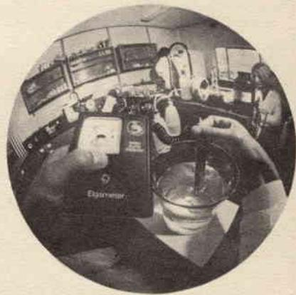
Fig. 2 - Impiego pratico di un Elgometer nel controllo della purezza dell'acqua in un laboratorio scientifico.
